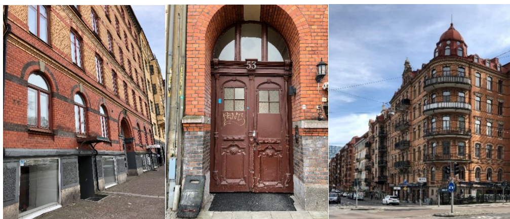
Byggnader på Engelbrektsgatans södra sida.
